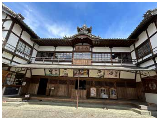
▲ 現在改修中の内子座
