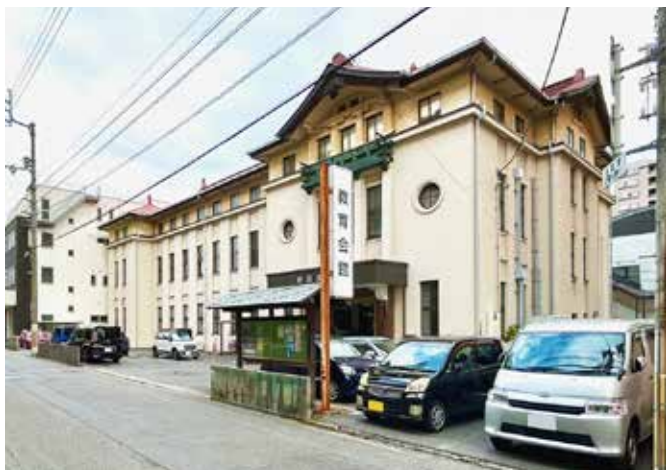
▲ 外観2（北西から）
