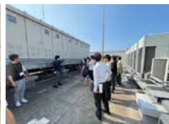
▲屋上設備スペース見学
