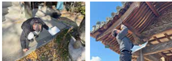
▲大師堂調査状況▲
