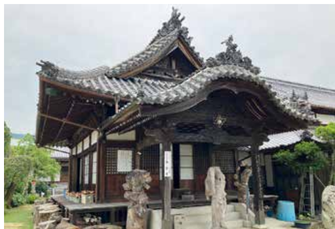
▲大師堂正面全景
