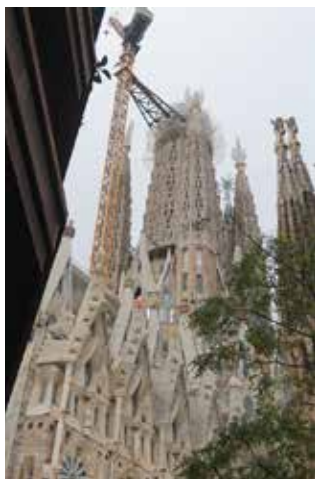
▲ 工事中のイエスの塔先端部
