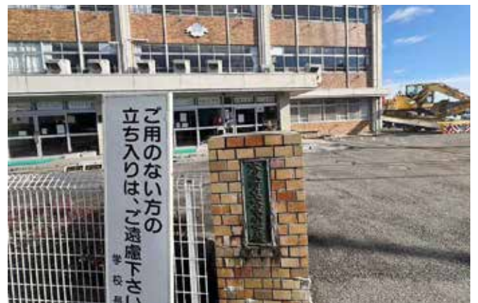
▲立ち入り禁止の穴水町穴水小学校
