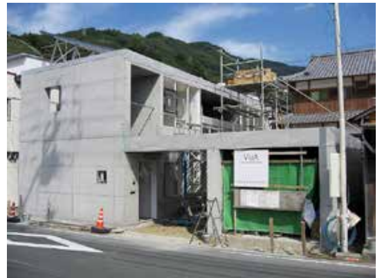
YM.House 躯体竣工
