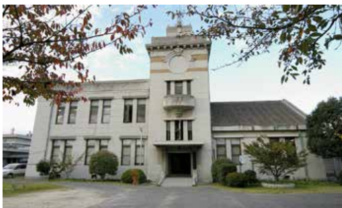
▲松山地方気象台 正面のファサード
