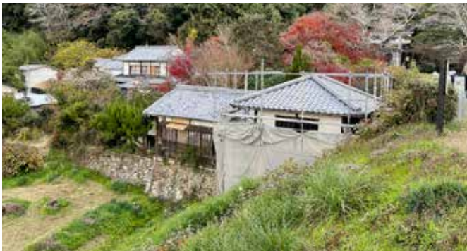
▲古学堂 向かって右側の足場がかかっているところが「文庫」
